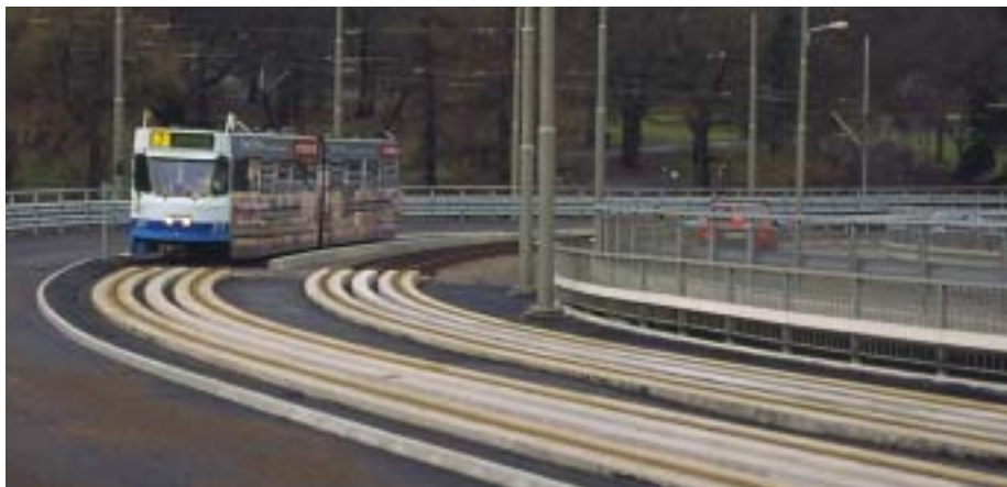
På broplattan över Dag Hammarskjöldsleden har spåren lagts i Edilonteknik och rännor i betongen tjänar som urspåringskydd; samma princip som i Chalmerstunneln.
