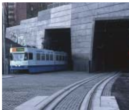
Tunnelmyningen vid Södra vägen; invid spåren syns kraftiga betongkonstruktioner som i berget förankrar tunnelns bottenplatta i betong. Med denna är i sin tur spåret förenat.
