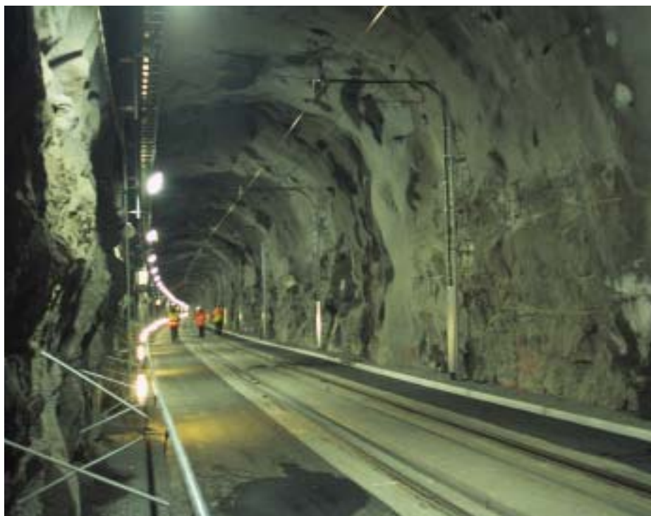
Chalmerstunneln består av två enkelspåriga tunnelrör i berg. För att undvika magnetfält har en kraftig förstärkningsledning dragits i kabeltrumman i de båda tunnelrören. Vid särskilt känsliga passager har på ungefär var 12:e meter en anslutningskabel från matarkabeln dragits upp till kontakttråden. Observera betongplattans kraftiga längsgående rännor som tjänstgör som urspåringskydd. Vignolrälerna är lagda i Edilonteknik.
