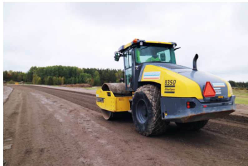
Pågående vägbygge vid väg 35, nära Hackefors, strax söder om Linköping.
